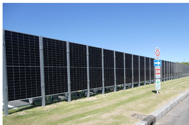
駐車場工場間 フェンス型太陽光発電
