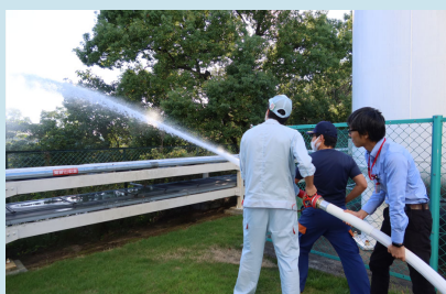
消火栓実放水訓練の様子
