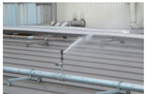
屋上散水システム作動中の様子
