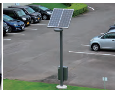
LED蓄電式街灯
